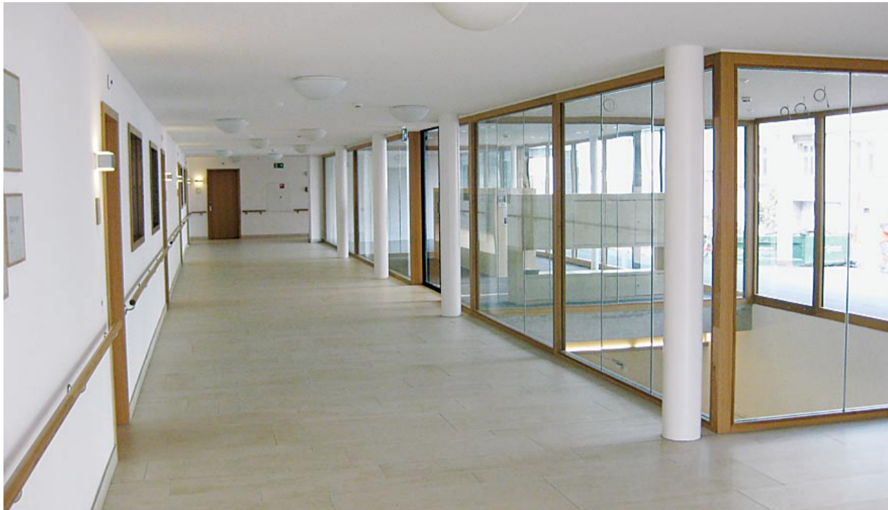
Hell und freundlich: Nicht nur der visuelle Eindruck, sondern auch die Haustechnik ist top.
